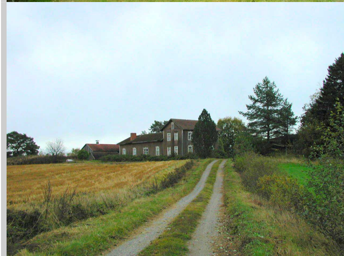
KUVA 13. Salmelan tilan vanha päärakennus. Tu- paosa on 1800-luvulta ja kaksi-kerroksinen osa vuodelta 1912. .
