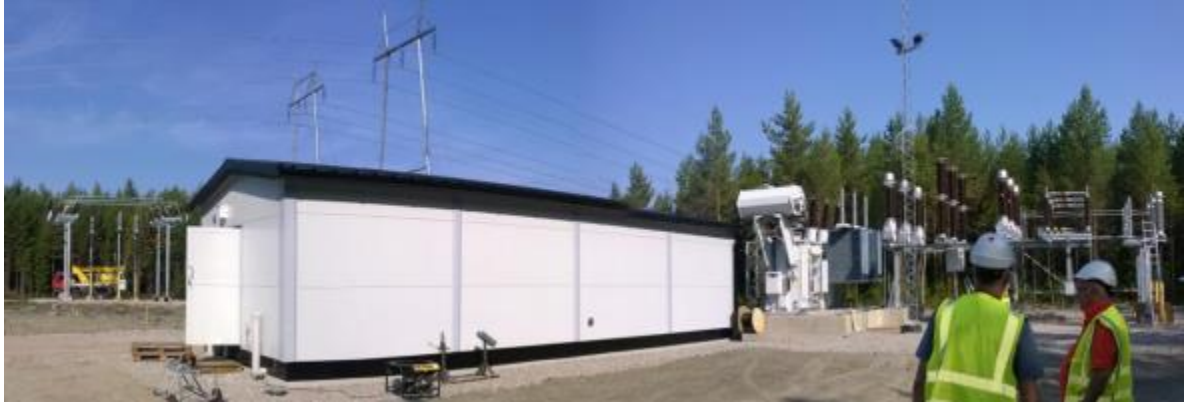
Kuva 14. Esimerkki rakenteilla olevasta tuulivoimapuiston sähköasemasta.
