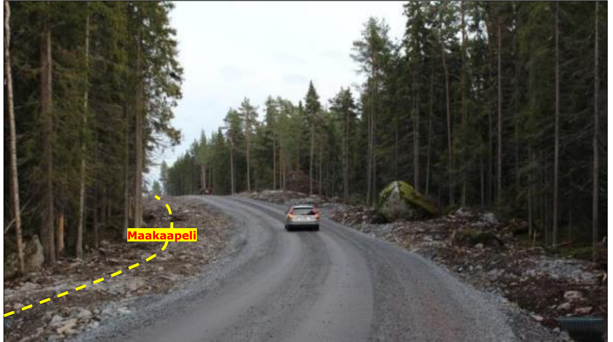
Kuva 12. Esimerkki tuulivoimapuiston rakennus- ja huoltotiestä. Teitä käytetään muun muassa betonin ja soran sekä voimaloiden komponenttien kuljetuksiin. Tuulivoimapuiston käyttövaiheessa teitä käytetään mm. vuosittaisissa huolloissa. Maakaapelin oja on sijoitettu tien vasemmalle puolelle.
