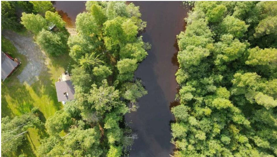
Kuva 11. Ilmakuva kanavan tulouoman edustasta.
