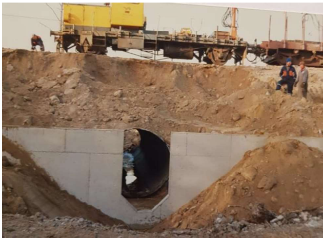
Kuva 6. Arkistokuva padon rakennustöistä.
