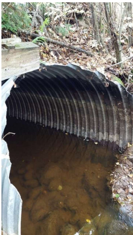
Kuva 3. Pohjoisen uoman rumpuputki syys-lokakuussa.
