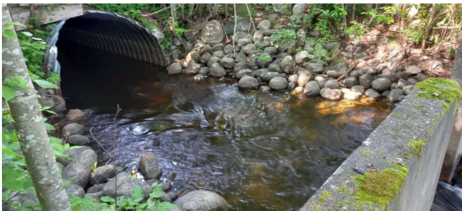
Kuva 2. Pohjoisen uoman rumpuputki heinäkuussa.
