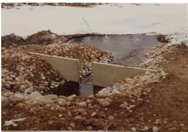
Kuva 7. Arkistokuva padon rakennustöistä.
