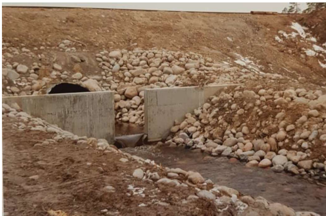
Kuva 8. Arkistokuva padon käyttöönotosta ja rakennuksenaikaisesta vesitilanteesta.
