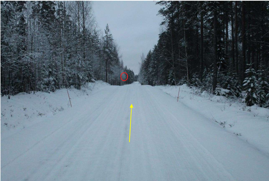
Kohta 42/Kuva 67. Tie 560. https://maps.app.goo.gl/ZD8yZS8jTQW3dwpC9 Harjanne. Tie on korjattava turbiinotoimittajan ohjeiden mukaisesti. Merkityt puun oksat on leikattava.
