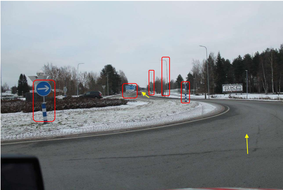
Kohta 7/kuva 13. Ensimmäinen liikenneympyrä tiellä 27. Jatka suoraan tietä 27. Merkityt kyltit ja valopylväät on poistettava.
