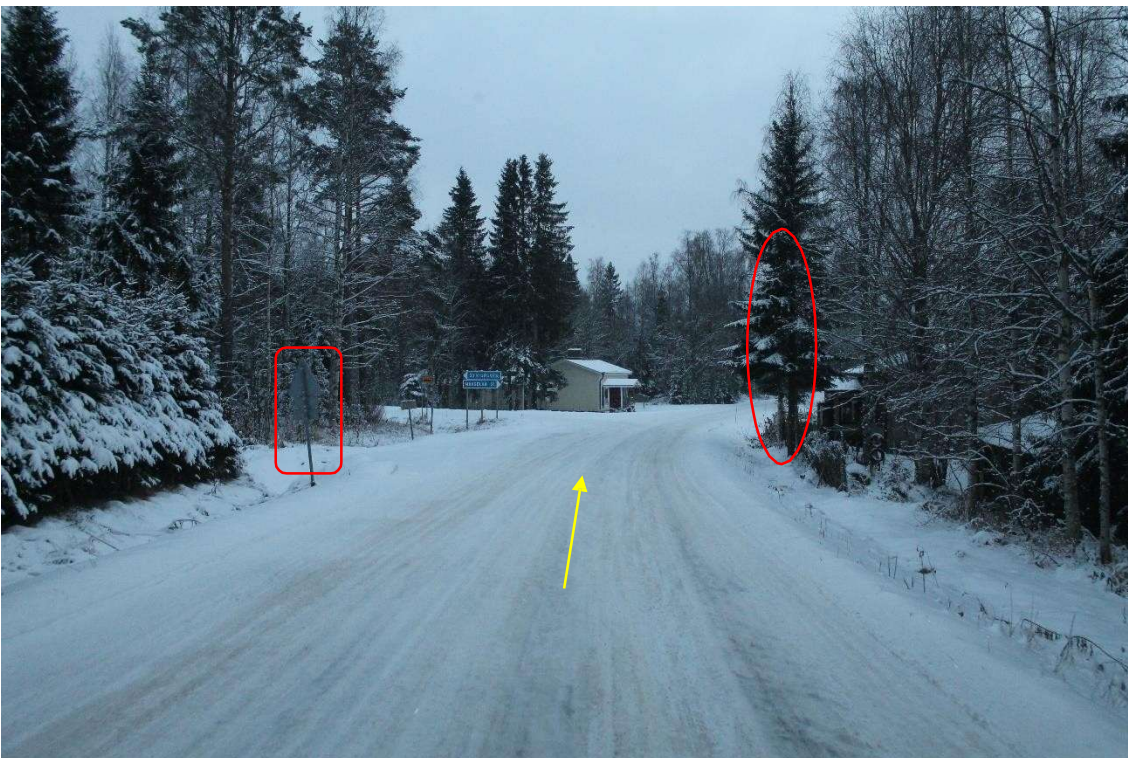
Sijainti 31/Kuva 52. Tie 560. Yksityisellä alueella merkityt puut on kaadettava. Merkitty kyltti on poistettava.
