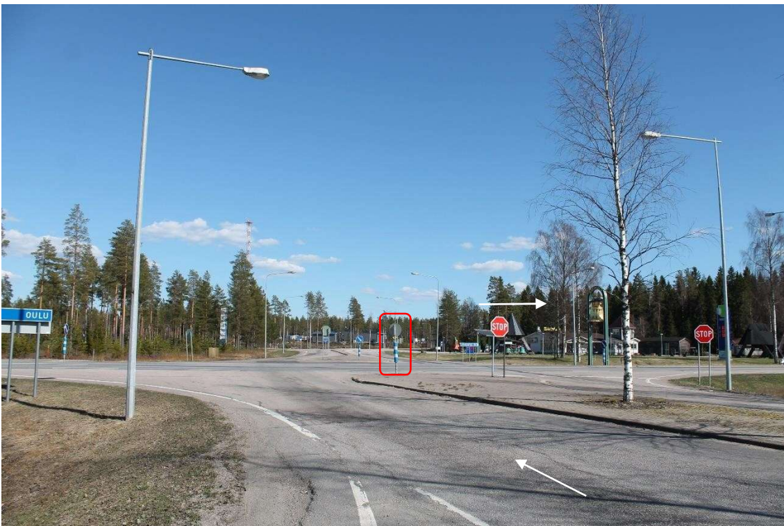
Pos 24/Kuva 72. Käänny tieltä 27 tielle 4. Merkitty kyltti on poistettava. Tästä eteenpäin reitti poikkeaa työmaalle johtavasta reitistä. Valkoinen nuoli osoittaa tornien ajosuunnan.
