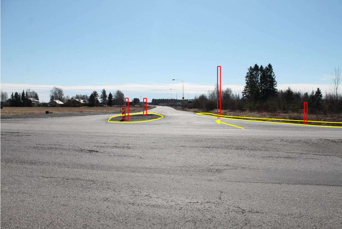
Pos 4/Kuva 9. Käänny tieltä 8 tielle 27. Merkitty lamppupylväs (puuttuu) ja liikennemerkit (puuttuvat) on poistettava. Merkityt alueet on täytettävä.
