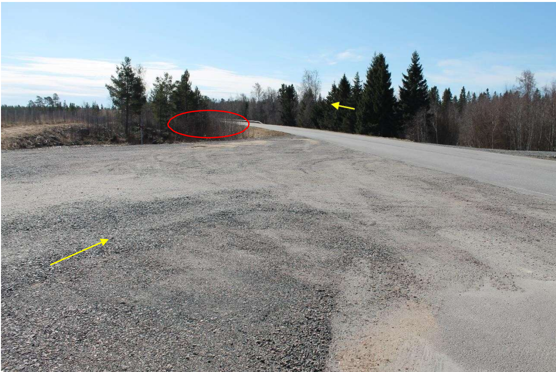
Pos 1/Kuva 2. Poistu Kalajoki satamasta kohti tietä 7771. Merkitty pensas on leikattava.
