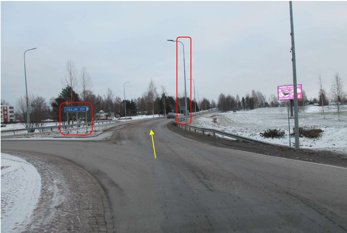
Kohta 8/Kuva 17. Toinen liikenneympyrä tiellä 27. Jatka suoraan tietä 27. Merkityt liikennemerkit ja valopylväs on poistettava.
