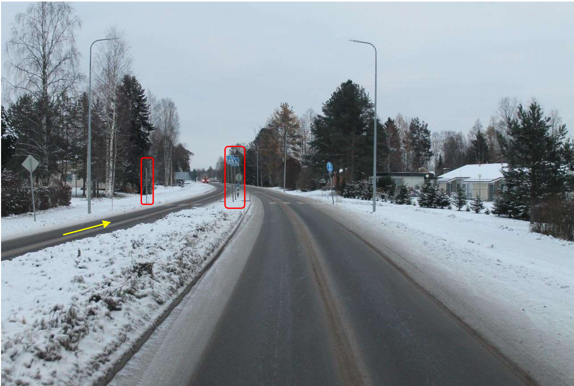
Kohta 21/Kuva 36. Tie 27 Haapajärvellä. Merkityt liikennemerkit on poistettava.
