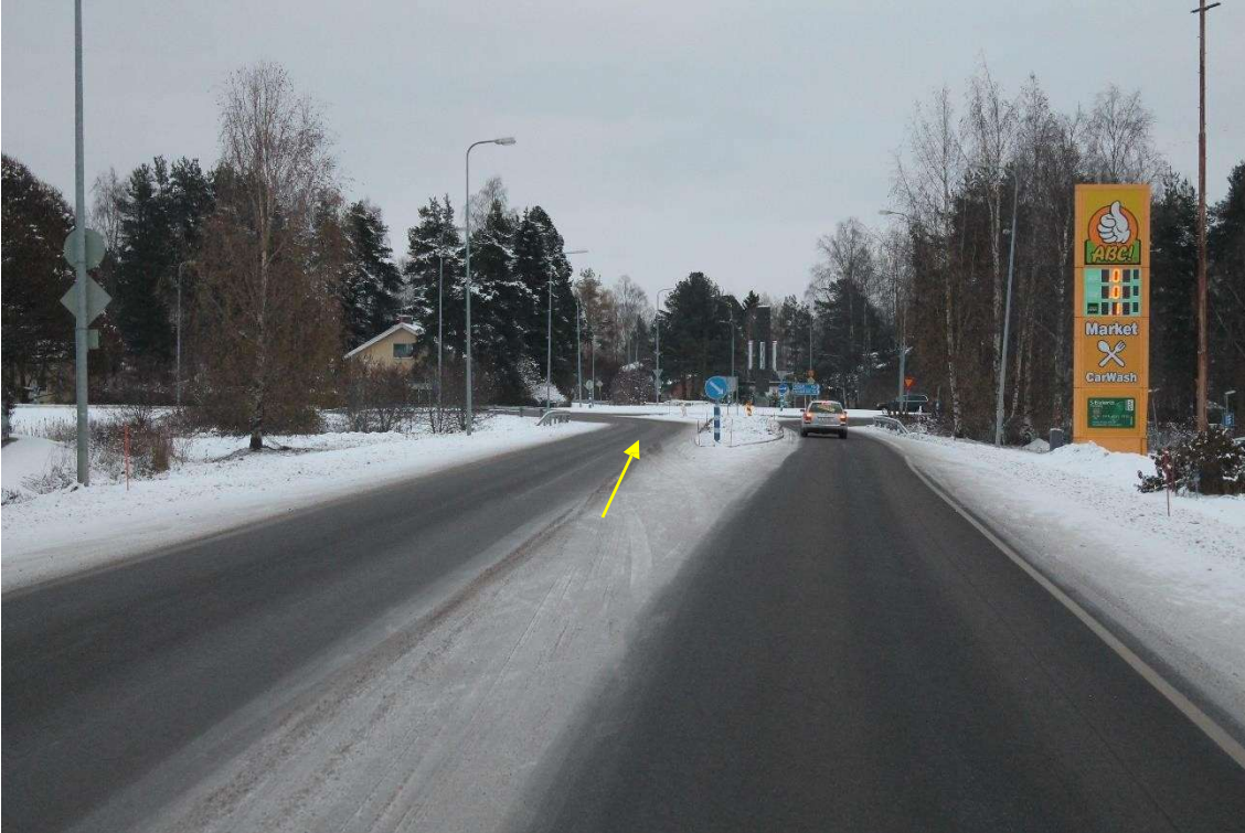
Kohta 21/Kuva 33. Tie 27 Haapajärvellä. https://goo.gl/maps/7HpqnuQfrn9onqKp6 Vastakkaista kaistaa on käytettävä.
