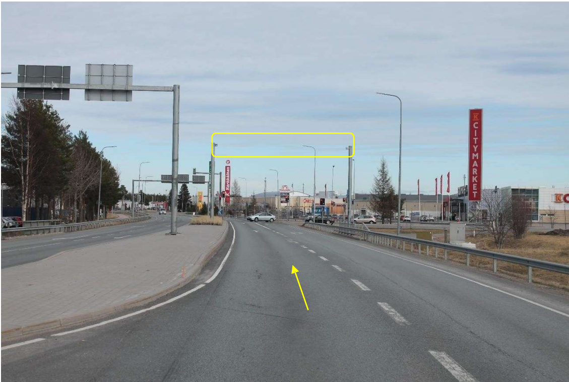
Pos 10/Kuva 19. Tie 27 Ylivieskassa. https://goo.gl/maps/HB4hU8AYi14DyQkU7 Merkitty portaali puuttuu, korkeus ennen 7,50 m.
