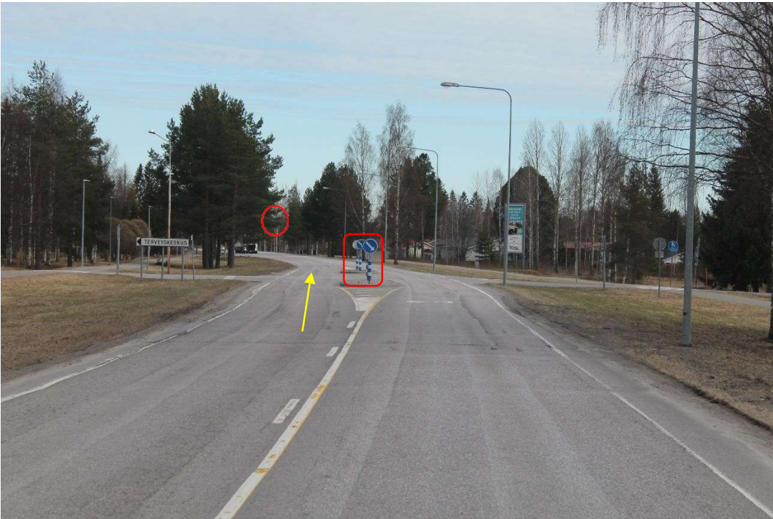
Pos 19/Kuva 31. Tie 27 Haapajärvellä. https://goo.gl/maps/AqL5cLpBu11soGA66 Vastakkaista kaistaa on käytettävä ja merkityt kyltit on poistettava. Merkityt puiden oksat on leikattava.
