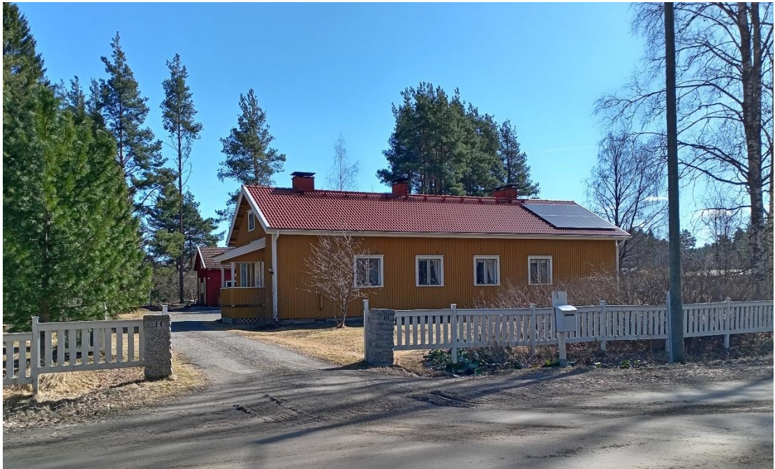
Kuva 10. Rautatieläisten asuinrakennus. Piharakennuksen pääty erottuu päärakennuksen takana. Kuva © Pihtiputaan kunta 2025.
