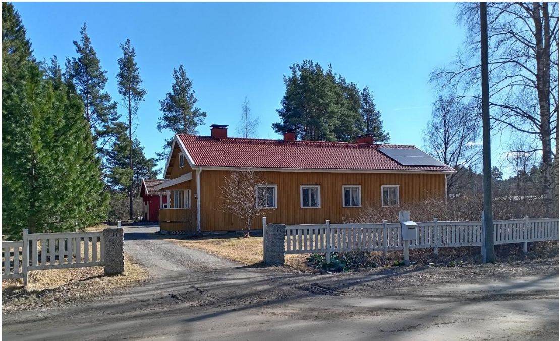
Kuva 13. Rautatieläisten asuinrakennus. Piharakennuksen pääty erottuu päärakennuksen takana. Kuva © Pihtiputaan kunta 2025.
