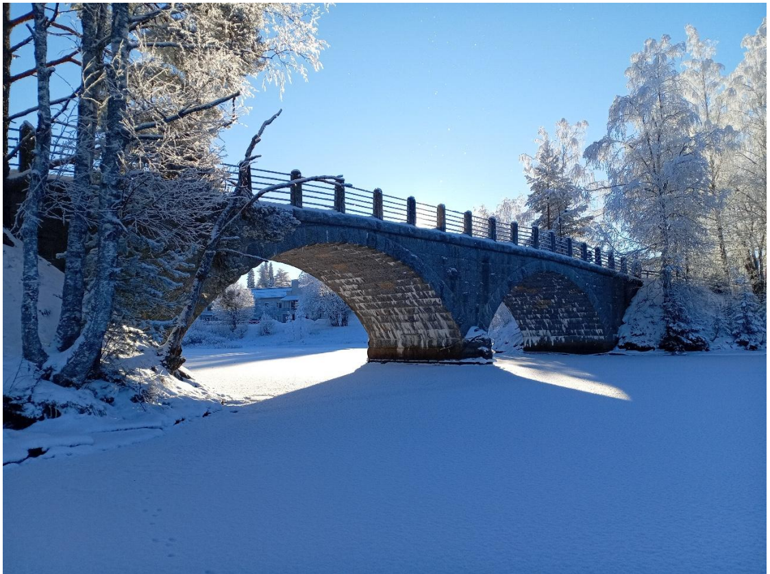
Kuva 4. Heinäjoen silta talvipäivänä. Kuva © Pihtiputaan kunta 2026.
