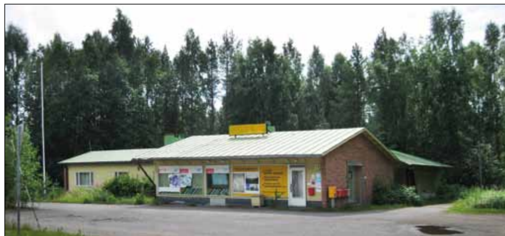
Kaupankäynnin rakennettuja kulttuuriympäristöjä inventointialueella edustavat lähinnä muutamat entiset kyläkaupat. Kauppatoiminta on kuitenkin niissä loppunut. Kuvassa Elämjärven entinen kyläkauppa.
