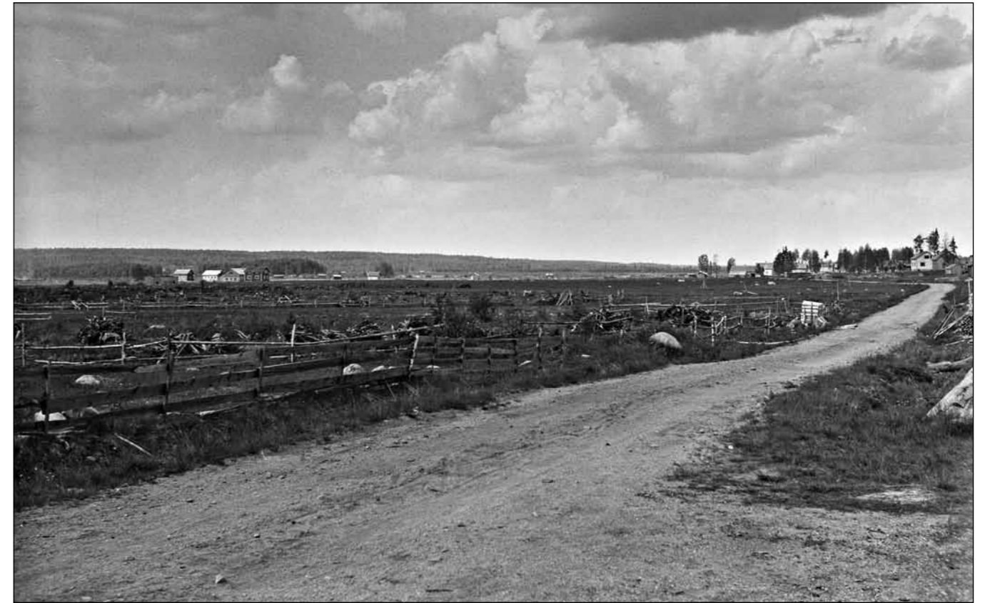
Valokuva Liitonjoelta pian tilojen raivaamisen jälkeen.
