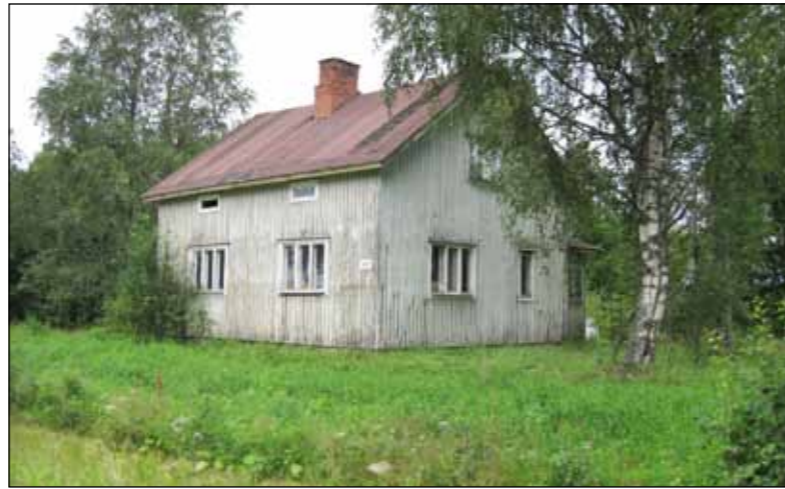
Jälleenrakennuskauden asuintaloihin on tehty monenlaisia korjauksia. Liitonjoella alkuperäisessä asussa on säilynyt lähinnä autioituneita taloja.
