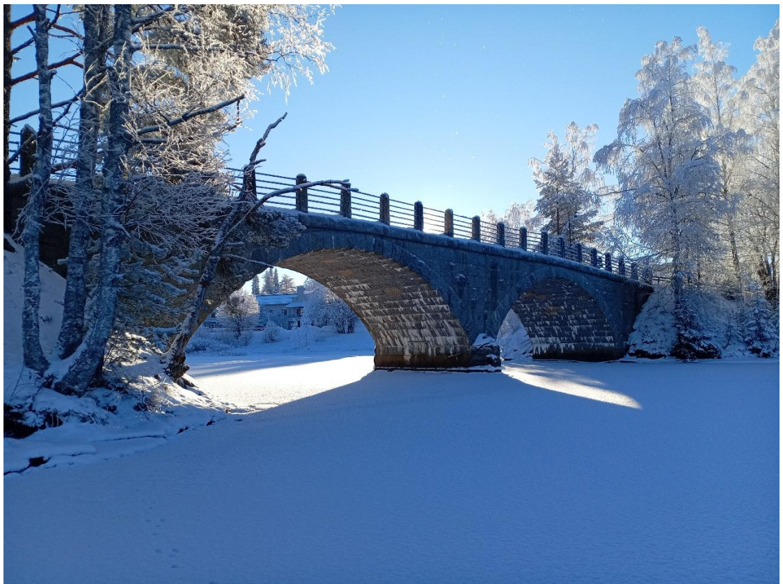
Kuva 4. Heinäjoen silta talvipäivänä. Kuva © Pihtiputaan kunta 2026.
